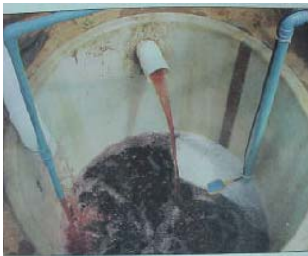
Fotografía N° 6.9. Turbulencia originada al retornar la solución al estanque colector.
